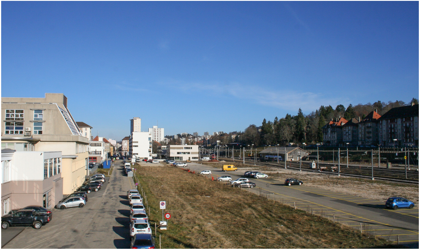
Les secteurs encore en friche appelés à accueillir les nouvelles constructions devant l'îlot B (bâtiments blancs au fond), vus depuis le pont de la H20. Pour assurer le lien avec la gare, il est essentiel que la rue sans caractère à gauche devienne à terme la voie verte dédiée à la mobilité douce, telle que prévue dans le plan spécial. Photo: A. Beuret, EspaceSuisse
