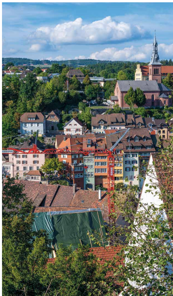
La commune a jusqu'ici investi env. 10 millions de francs dans quatre objets, deux dans la vieille ville de Laufenburg et deux dans la localité de Sulz.
